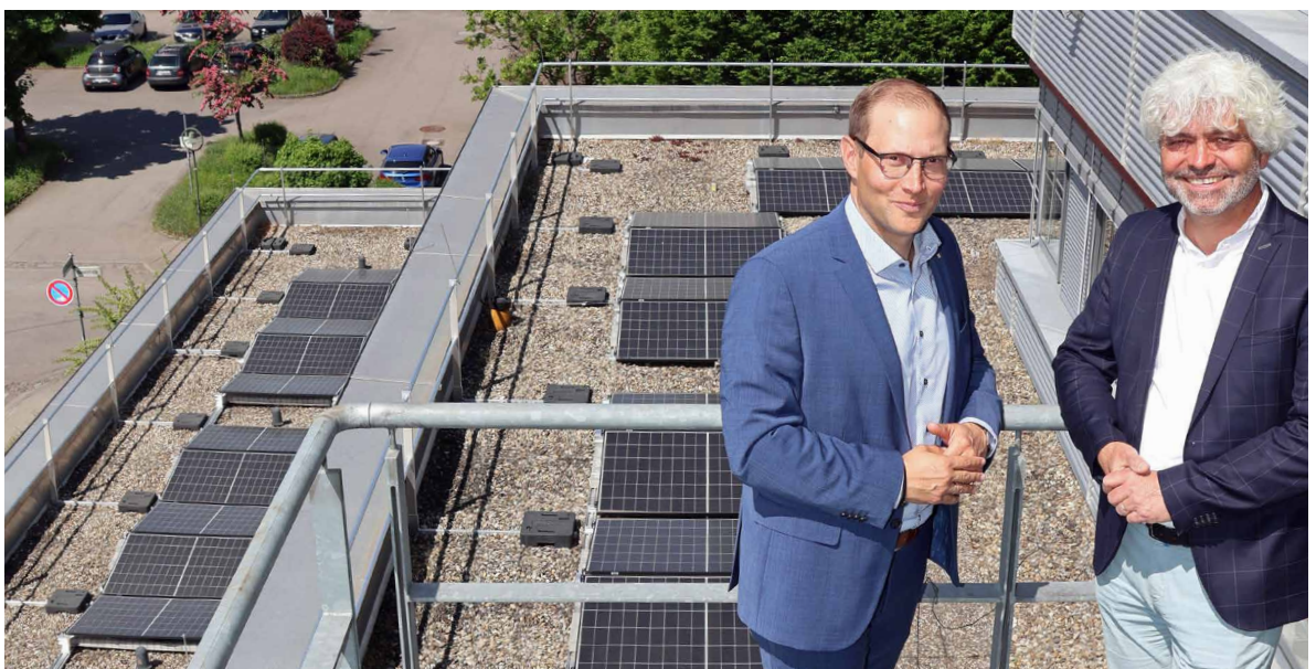
Die PV-Anlage an der Philipp-Matthäus-Hahn-Schule.
