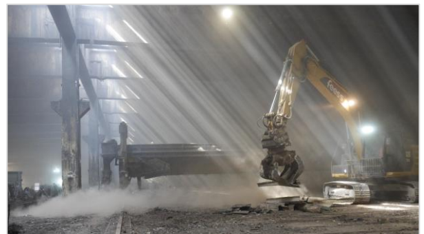
Abrissarbeiten in der 130 Meter langen Rottehalle.
